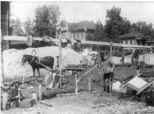
Строительство корпуса по ул. Первомайской, 1949 г.
