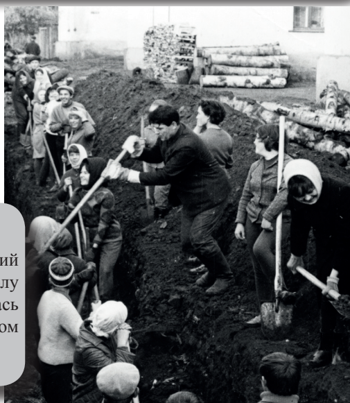
Комсомольцы на строительстве общежития. 1969 год.
